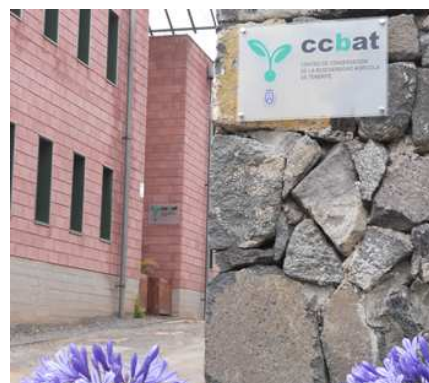
Fotografía 47-. Instalaciones del CCBAT.
